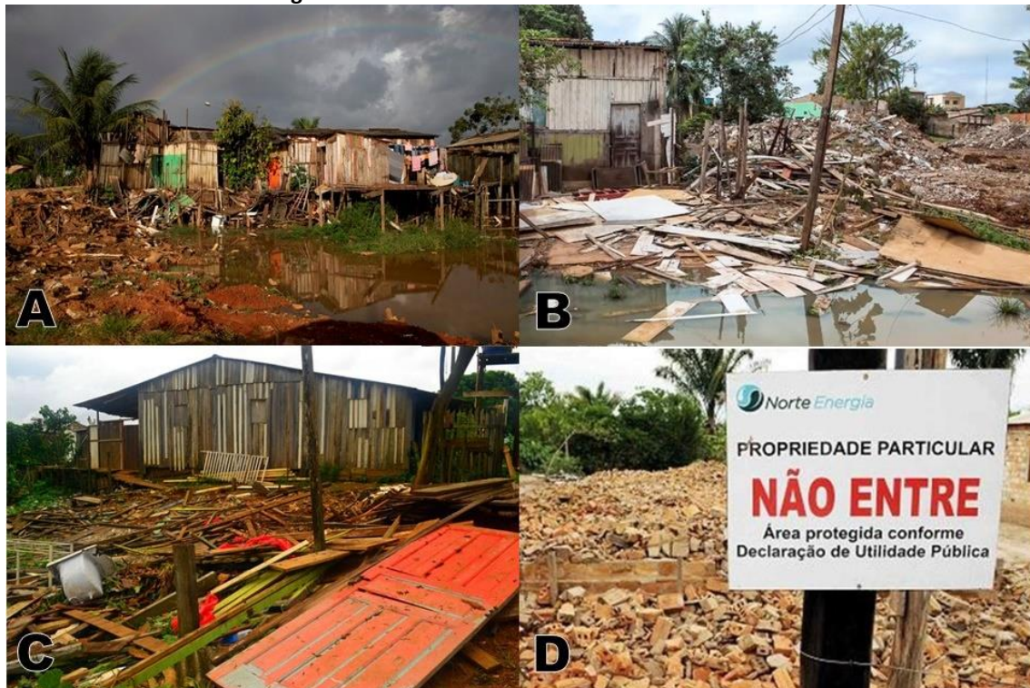
Figura 4: Casas Demolidas nos Baixões de Altamira
